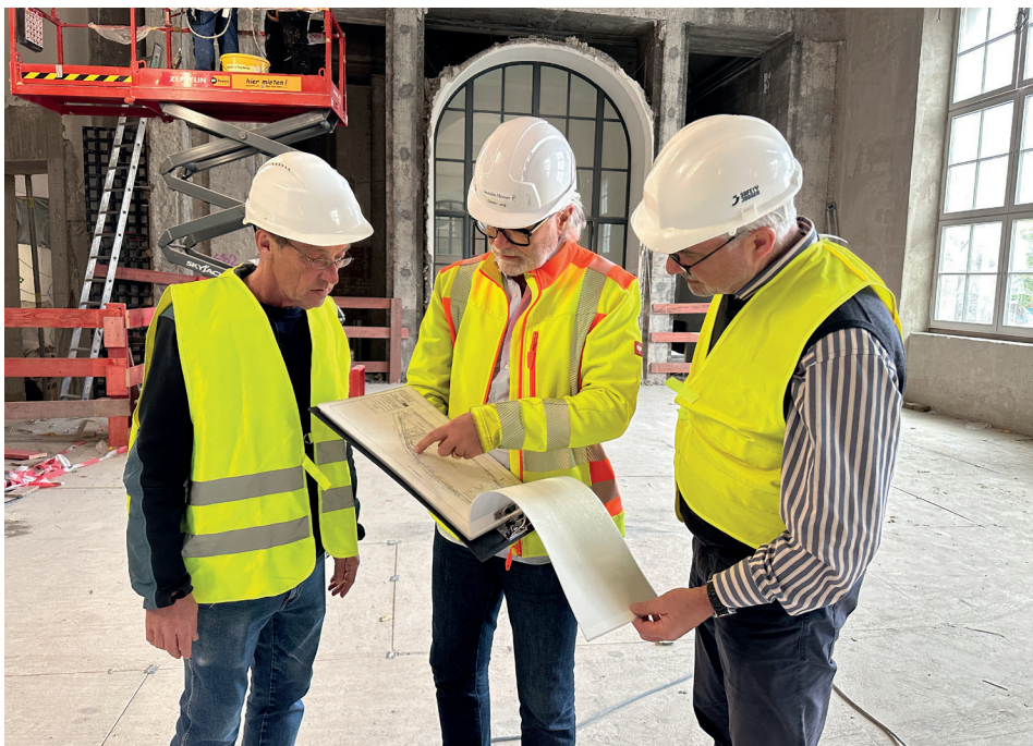
Steffen Scheurer (rechts) im Gespräch mit Gerrit Faust (Leitung Stabsstelle Kommunikation am Deutschen Museum) und Dieter Lang (Bereichsleiter und Generalbevollmächtigter Bau).
