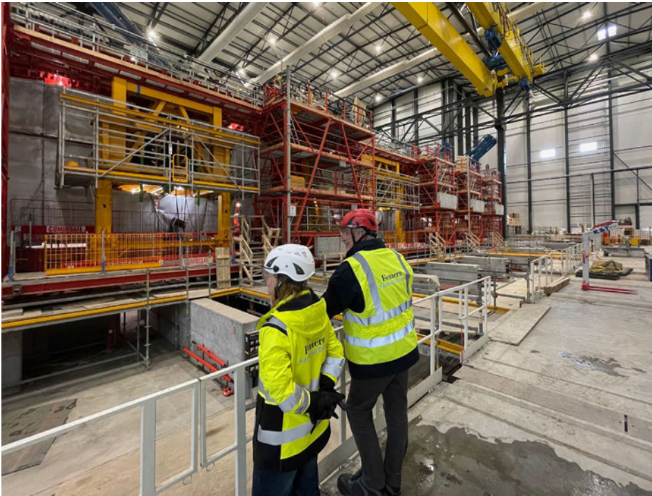
In der Betonieranlage wird das Stahlskelett – der Bewehrungskorb – in einem Guss mit Beton gefüllt. Foto: Oliver Steeger
