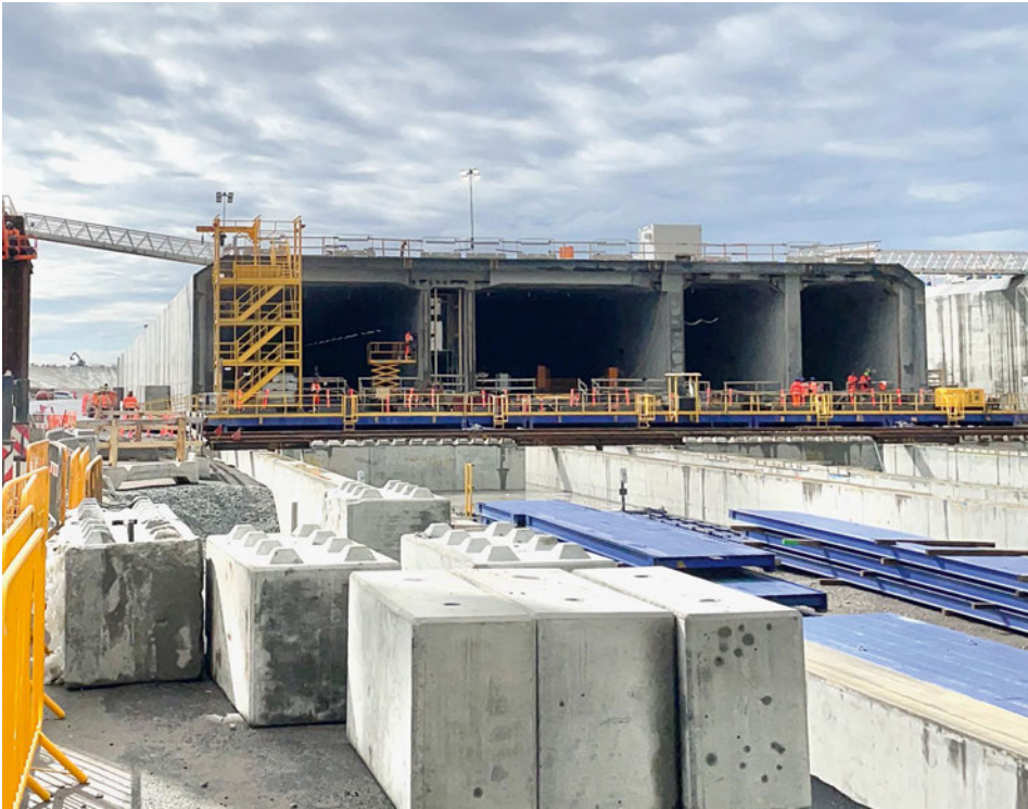
Ein Tunnelement vor der Fabrik, im nicht gefluteten Becken. Foto: Oliver Steeger
