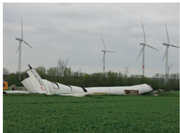
Abbildung 3: Systematisches RePowering, die Windkraftanlagen der ersten Generation sind längst neuen, modernen, leistungsfähigeren Anlagen gewichen
