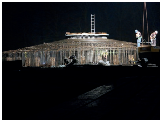
Abbildung 7: Terminverzug und Kostendruck führen dazu, dass die Arbeit am Fundament der Anlage nachts bei Flutlicht fortgeführt wird; hier in einem Versuchsfeld in der Südermarsch
