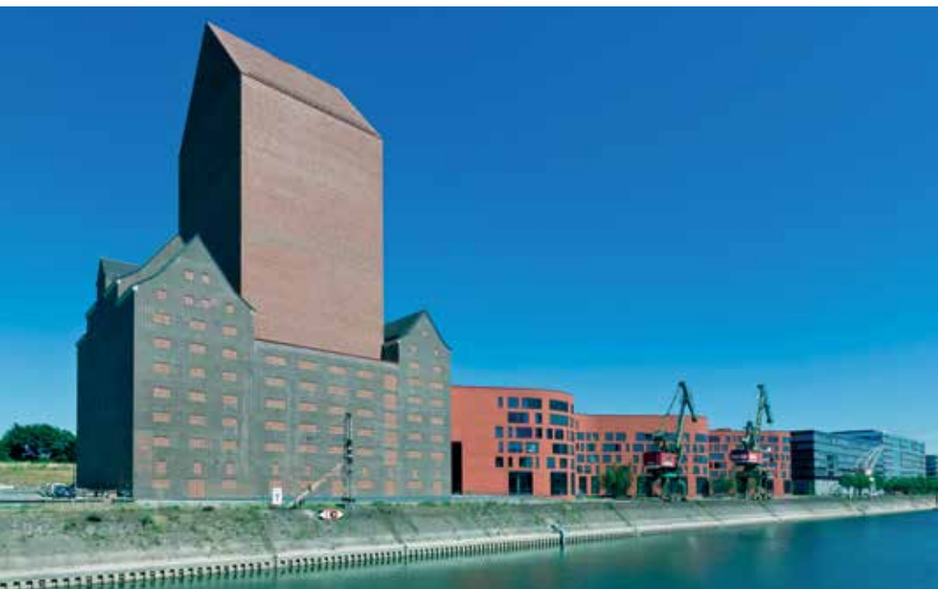
Projekt „NRW-Landesarchiv“: Der Bau besteht aus einem revitalisierten ehemaligen Speichergebäude und einem wellenförmigen Neubau. Das Mitte 2013 eingeweihte größte Archiv Europas bietet 134 Kilometer Regalplatz. Foto: HOCHTIEF
