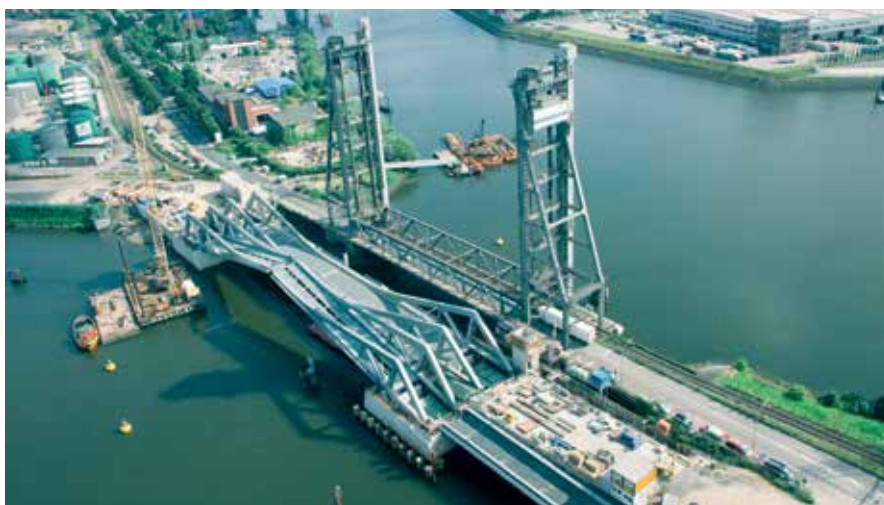
In Hamburg realisiert HOCHTIEF in einer Arbeitsgemeinschaft den Neubau der Rethelklappbrücke, mit einer Spannweite von 104,2 Metern eine der größten Klappbrücken Europas. Die Arbeiten starteten 2011 und sollen 2017 abgeschlossen werden. Die Brücke gilt als eines der wichtigsten Infrastrukturprojekte im Hafen der Hansestadt. Foto: Sky View Imaging
