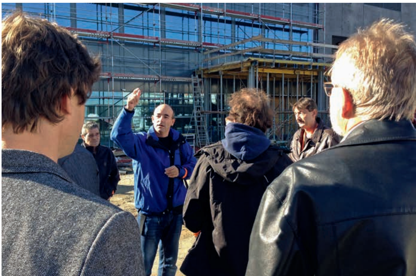
Stakeholdermanagement live – eine Führung auf der Baustelle; Foto: Swisscom
