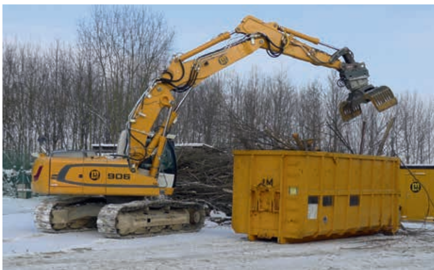
Baubeginn an kalten Tagen: erste Vorbereitungen für den Neubau des Data Centers; Foto: Swisscom
